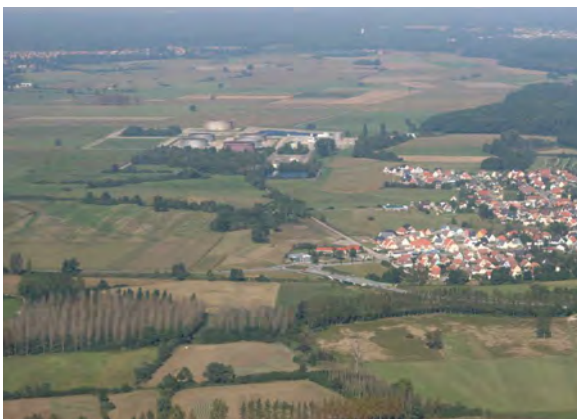
Les dépôts pétroliers de TOTAL sont classés établissements SEVESO à risque haut
