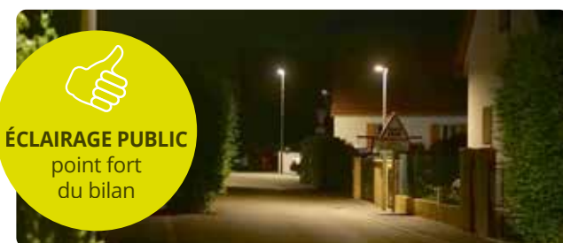
Les LED permettent un éclairage ciblé sur la chaussée
